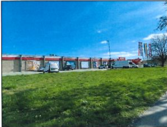
Abbildung 6: Blick auf den Rewe-Markt, Blickrichtung Norden
